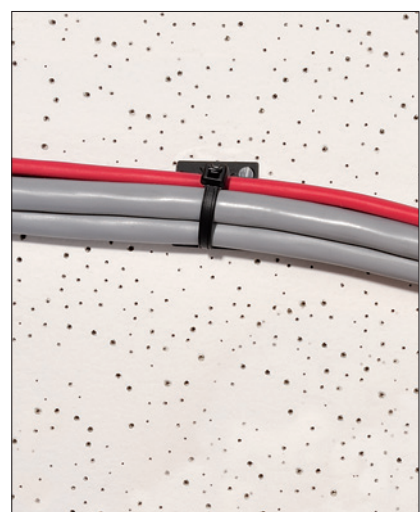
Ist die Installation fertiggestellt, wird der Q-tie wie üblich angezogen und abgebunden.
