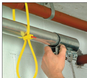
SpeedyTie ist für die temporäre, aber starke Befestigung besonders geeignet.
