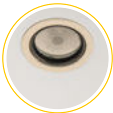
1. Alte Deckeneinbauleuchte mit größerem Deckenausschnitt.
