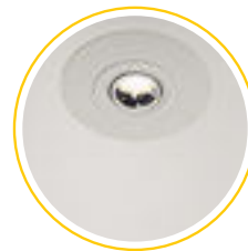
6. Neue Deckeneinbauleuchte in Reduzierring platziert.
