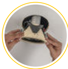
2. Deinstallation der alten Deckeneinbauleuchte.
