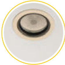
1. Alte Deckeneinbauleuchte mit größerem Deckenausschnitt.
