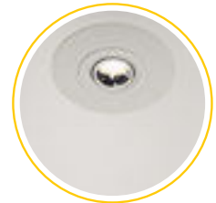
6. Neue Deckeneinbauleuchte in Reduzierring platziert.
