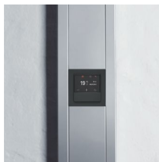
Steilvorlage: senkrecht montierter Edelstahlkanal mit KNX-Temperaturregler
